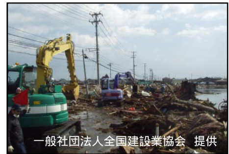
【陸域の啓開・応急復旧作業状況】
