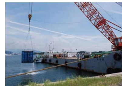
クレーン付き台船によるコンテナ引き揚げ
