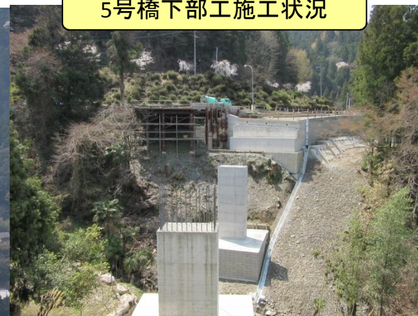
5号橋下部工施工状況
