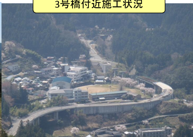
3号橋付近施工状況
