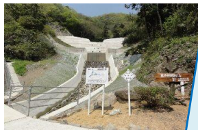
○砂防堰堤の整備
