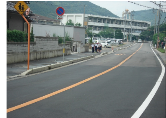
整備後 徳島上那賀線 中角工区(自歩道)
