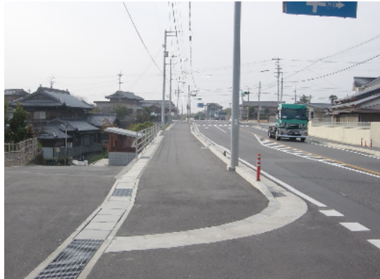
整備後 鳴門池田線 勝命工区(自歩道)
