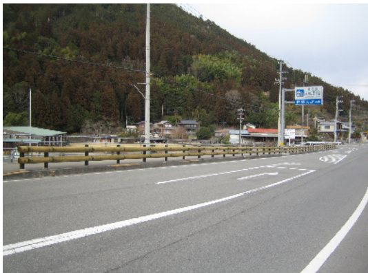
整備後 木製ガードレール整備事業
