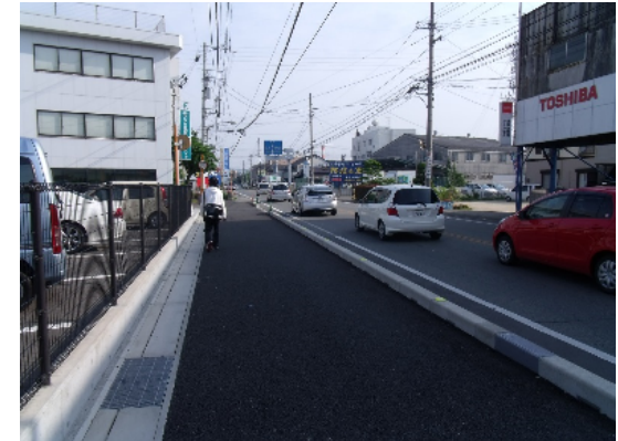
整備後 徳島鳴門線 鯛浜工区(自歩道)
