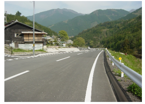
整備後 一般国道438号 森遠工区
