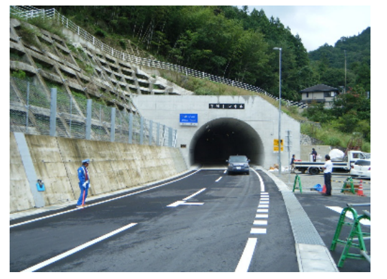
整備後 一般国道439号 落合バイパス工区
