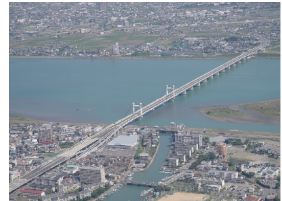
整備後 徳島環状線 阿波しらさぎ大橋工区
