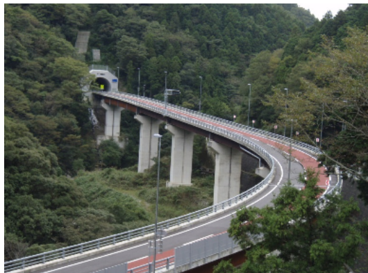
整備後 神山鮎喰線 養瀬工区
