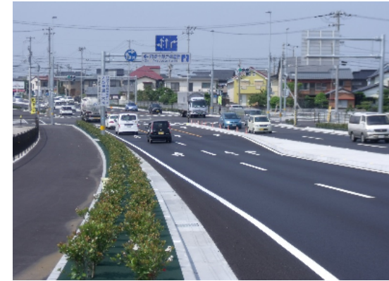
整備後 徳島環状線 川内工区
