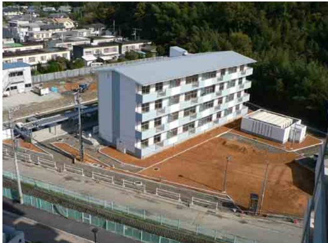
県営住宅名東(東)団地建替工事(平成20年度) 5号棟 RC造4階建 16戸
