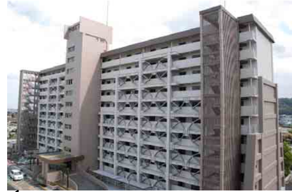
県営住宅小松島団地1号棟耐震改修工事 (平成23年度) 1号棟 RC造10階建て 100戸
