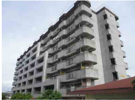
県営住宅金沢団地6・7号棟耐震改修工事 (平成25年度) 6号棟 RC造8階建て 64戸 7号棟 RC造8階建て 80戸
