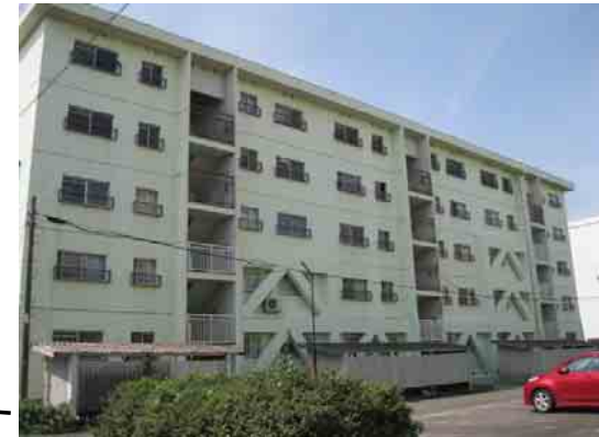
県営住宅羽ノ浦春日野団地27・28号棟耐震改修工事 (平成23年度) 27・28号棟共 RC造5階建て 30戸
