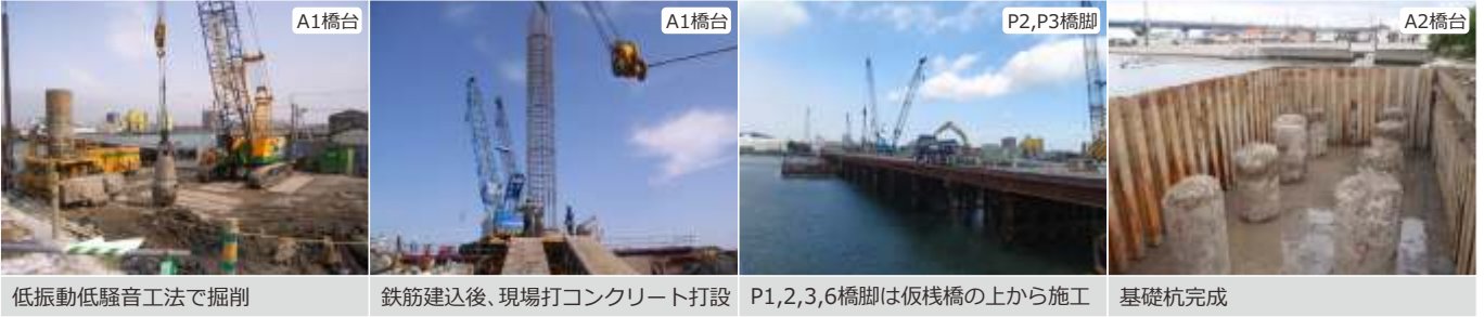
低振動低騒音工法で掘削 鉄筋建込後、現場打コンクリート打設 P1,2,3,6橋脚は仮栈橋の上から施工 基礎杭完成
