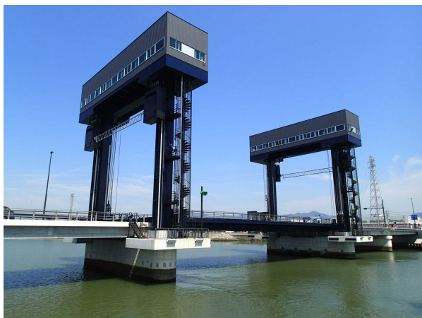
写真1：橋桁を降ろした状況
