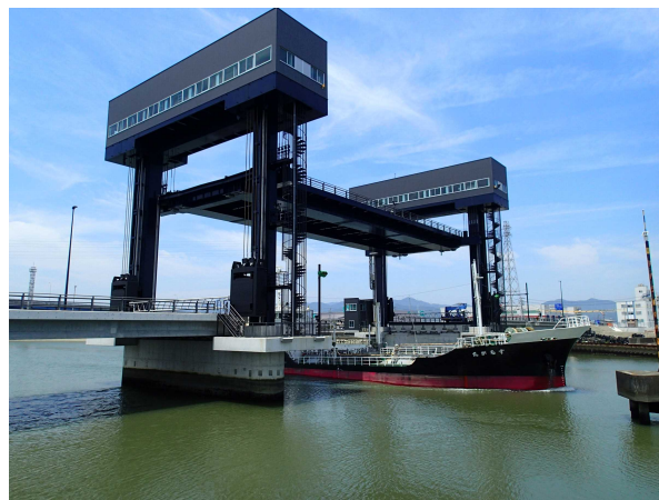
写真2：船舶が航行する状況（橋桁上昇）
