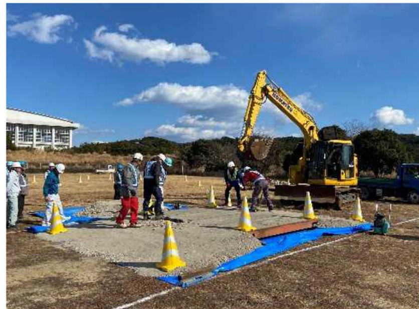
（段差の応急復旧：土佐国道事務所）
