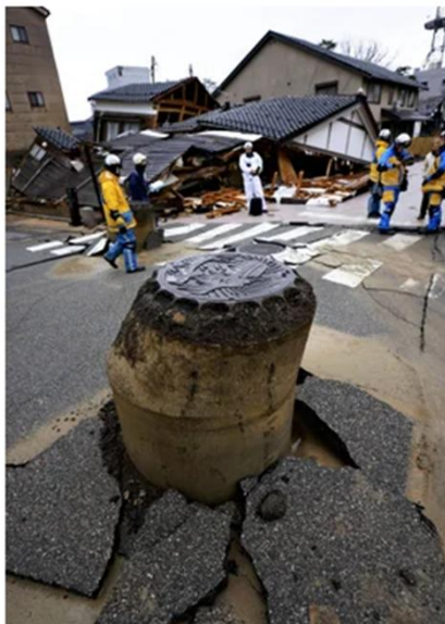
・マンホールの浮き上がり
