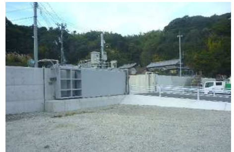
牟岐漁港海岸(楠ノ浦地区)での 津波・高潮対策のための陸閘
