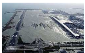
関西国際空港の水没状況
