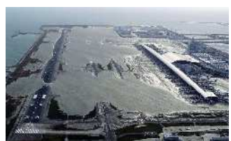
関西国際空港の水没状況
