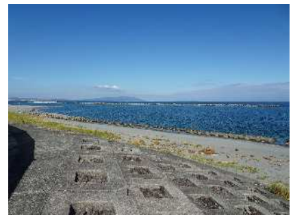
今切港海岸の緩傾斜護岸
