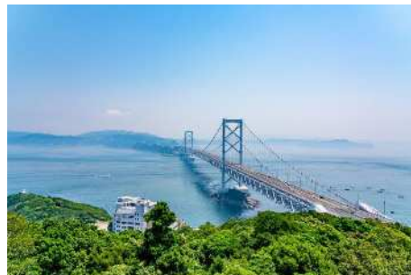
関西方面を結ぶ本四連絡橋
