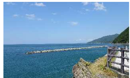
折野港海岸大須地区 の沖合防護対策
