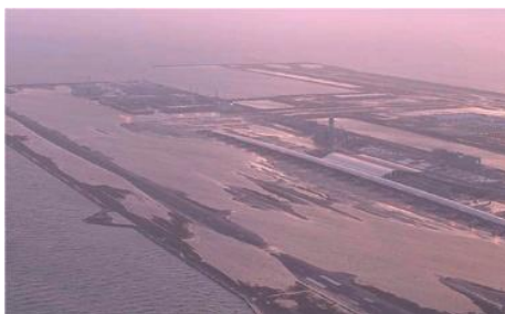
高潮による関西空港の水没状況
