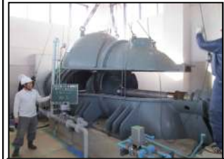
ポンプのオーバーホール
