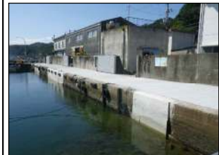
漁港物揚場の補修
