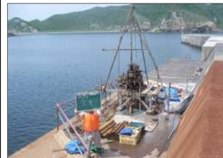
漁港堤防耐震点検
