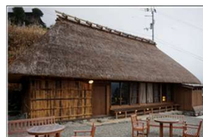
活用事例：宿泊施設
