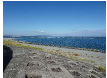
今切港海岸の緩傾斜護岸
