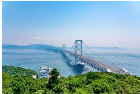
関西方面を結ぶ本四連絡橋
