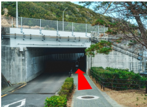
渦の道に向かう歩道ルート
