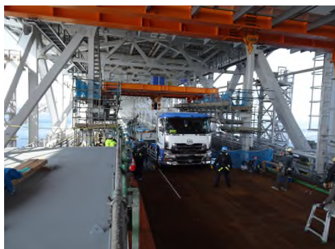
トラックによる部材運搬
