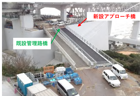
1A(兵庫県側)施工完了
