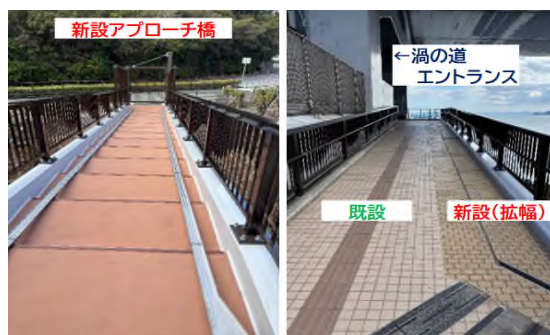
5A(徳島県側)施工完了
