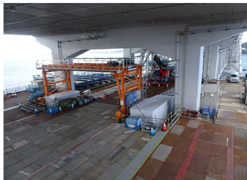
仮設構台・地組立ヤード
