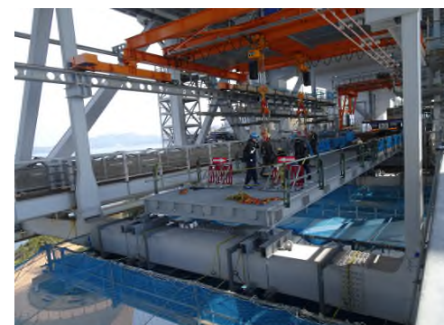
天井クレーンによる吊上げ・運搬・架設
