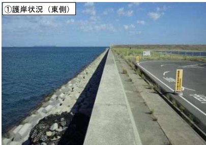
①護岸状況（東側）
