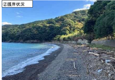
②護岸状況
