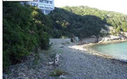
②護岸状況
