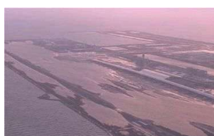
関西国際空港の水没状況
