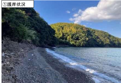
①護岸状況
