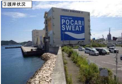
③護岸状況
