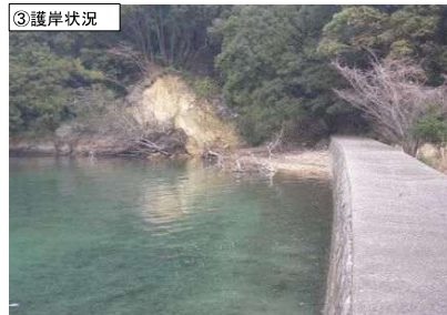
③護岸状況
