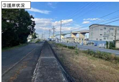
③護岸状況
