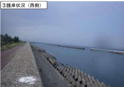
③護岸状況（西側）
