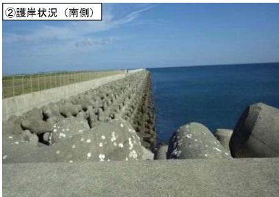
②護岸状況（南側）
