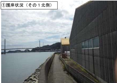
①護岸状況（その1北側）
