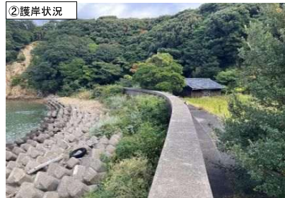
②護岸状況
