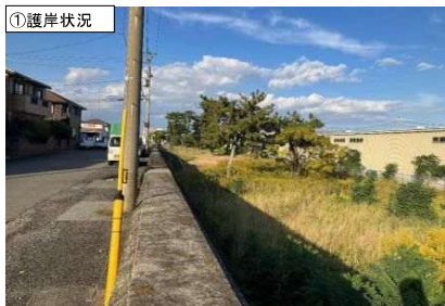
①護岸状況
