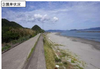
③護岸状況
