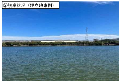
②護岸状況（埋立地東側）
