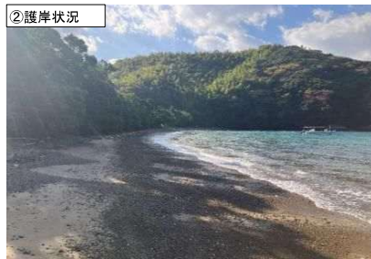
②護岸状況
