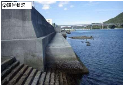
②護岸状況
