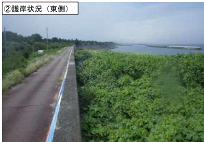
②護岸状況（東側）
