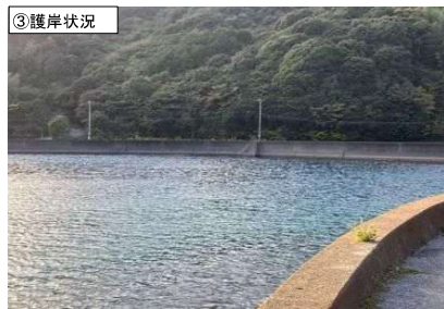
③護岸状況
