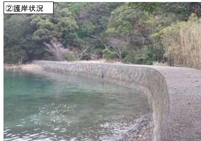
②護岸状況
