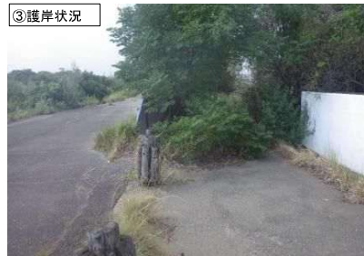
③護岸状況
