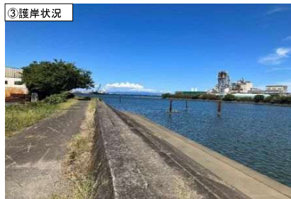
③護岸状況
