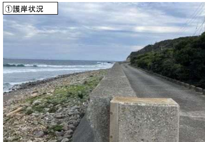
①護岸状況
