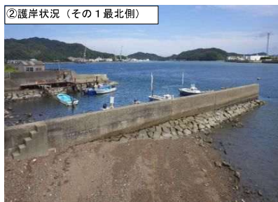
②護岸状況（その1最北側）
