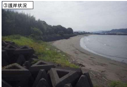
③護岸状況
