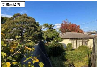
②護岸状況
