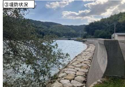
③堤防状況
