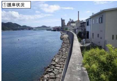
①護岸状況
