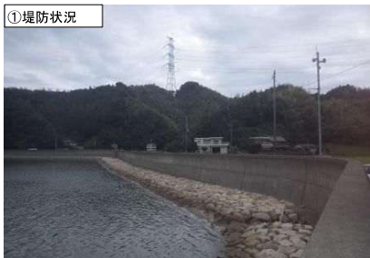
①堤防状況
