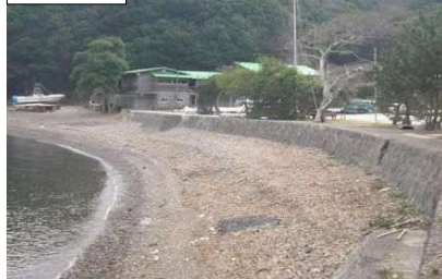
②護岸状況
