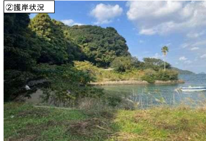
②護岸状況
