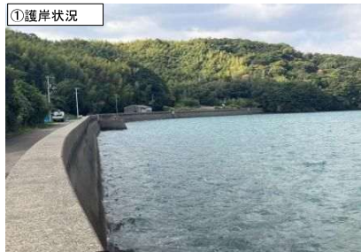
①護岸状況
