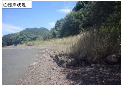
②護岸状況
