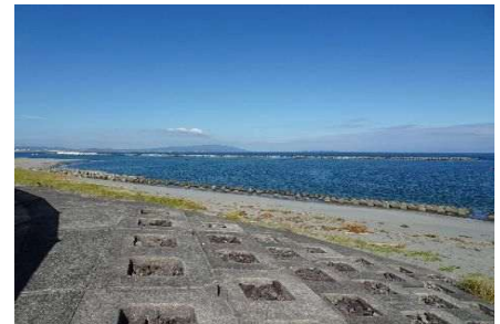
今切港海岸の緩傾斜護岸
