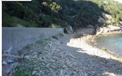
①護岸状況
