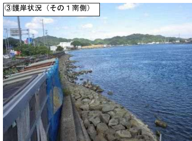
③護岸状況（その1南側）
