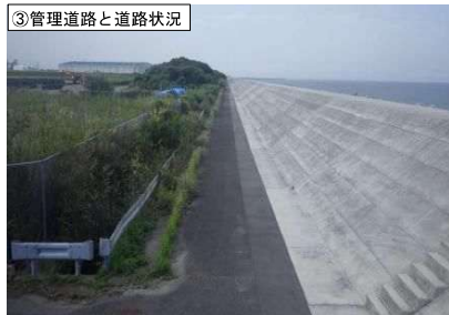
③管理道路と道路状況
