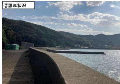
②護岸状況
