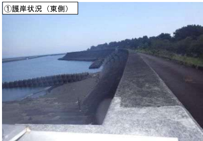
①護岸状況（東側）
