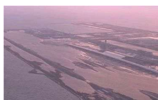
関西国際空港の水没状況
