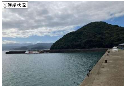
①護岸状況
