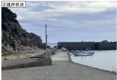
②護岸状況
