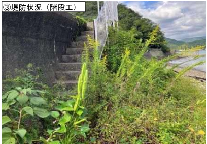
③堤防状況（階段工）
