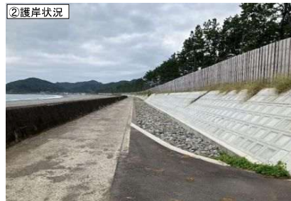
②護岸状況
