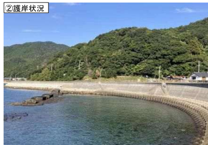
②護岸状況
