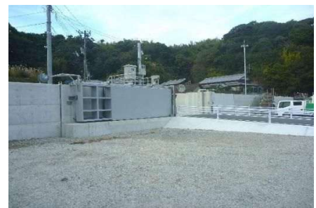
牟岐漁港海岸（楠ノ浦地区）での 津波・高潮対策のための陸開
