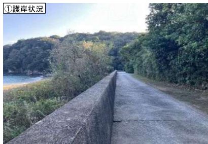
①護岸状況
