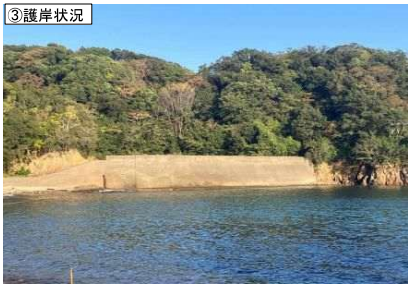
③護岸状況
