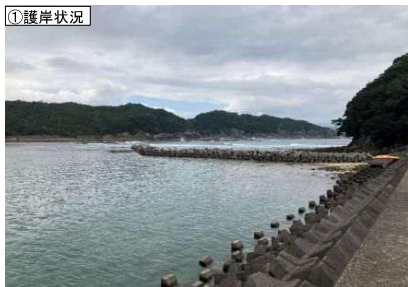
①護岸状況
