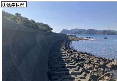
①護岸状況
