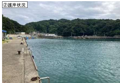
②護岸状況
