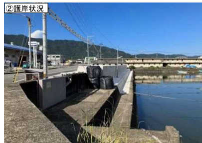
②護岸状況
