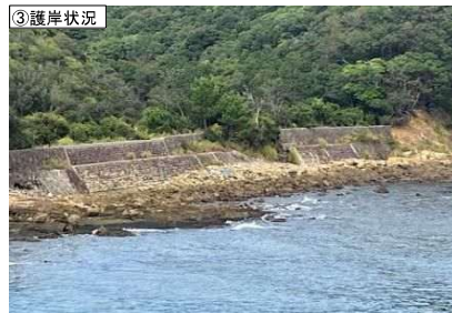
③護岸状況
