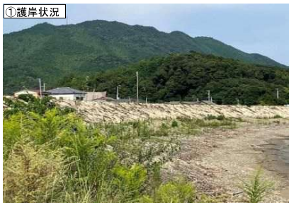
①護岸状況
