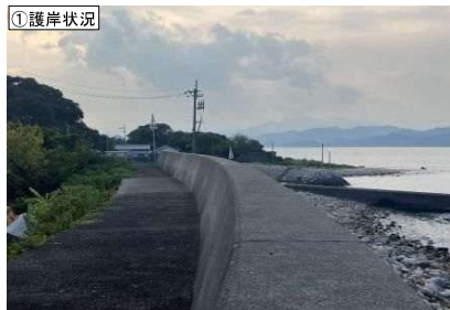
①護岸状況
