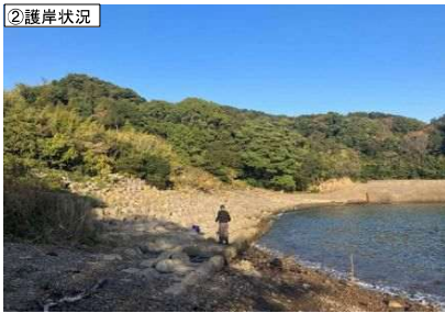
②護岸状況
