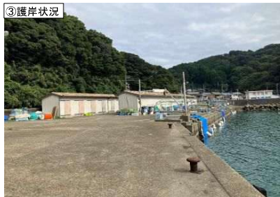
③護岸状況
