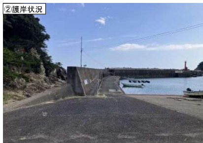
②護岸状況
