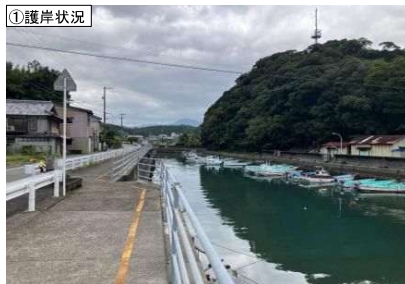
①護岸状況
