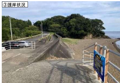
③護岸状況
