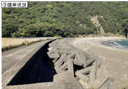
③護岸状況
