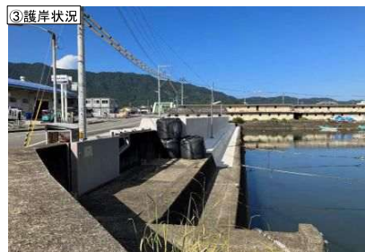
③護岸状況
