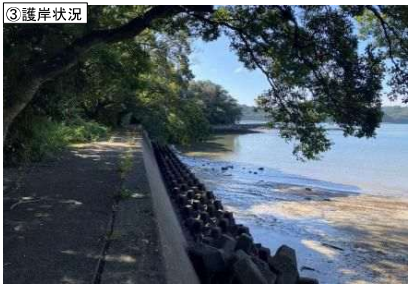
③護岸状況
