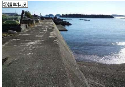
②護岸状況
