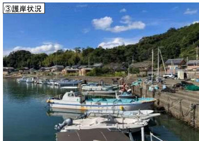
③護岸状況
