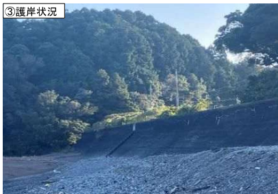
③護岸状況
