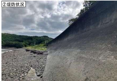
②堤防状況
