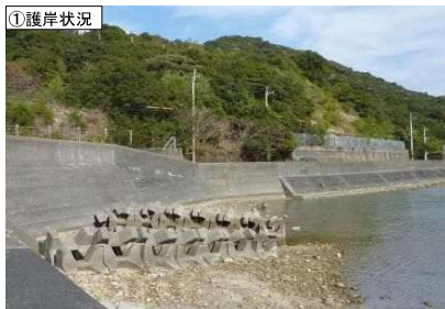
①護岸状況
