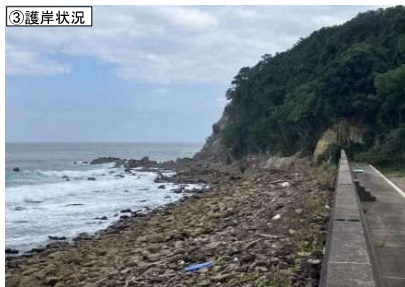
③護岸状況
