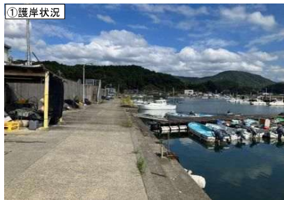
①護岸状況
