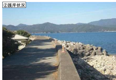
②護岸状況
