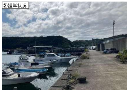
②護岸状況
