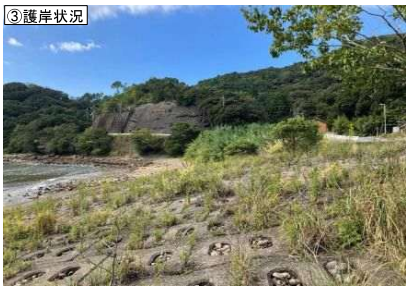
③護岸状況
