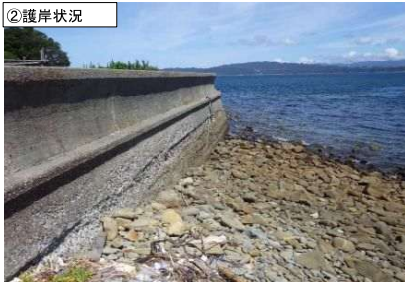
②護岸状況
