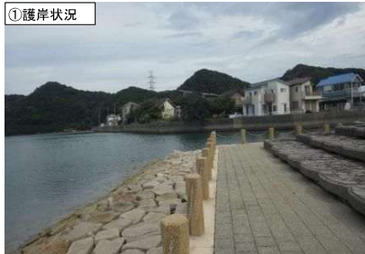
①護岸状況
