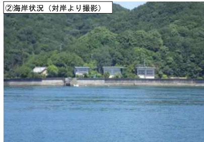
②海岸状況（対岸より撮影）
