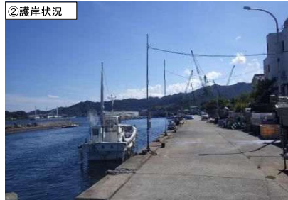
②護岸状況
