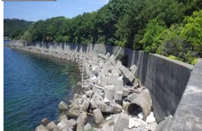
②護岸状況
