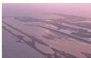
関西国際空港の水没状況
