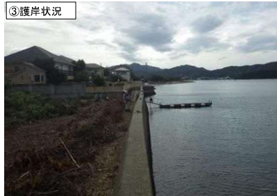
③護岸状況
