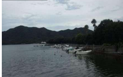
②護岸状況（北側）
