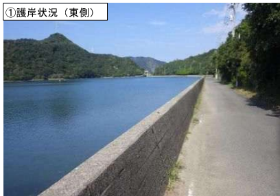
①護岸状況（東側）
