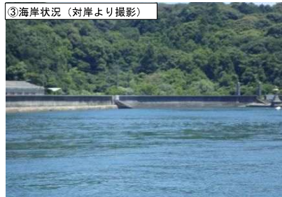
③海岸状況（対岸より撮影）
