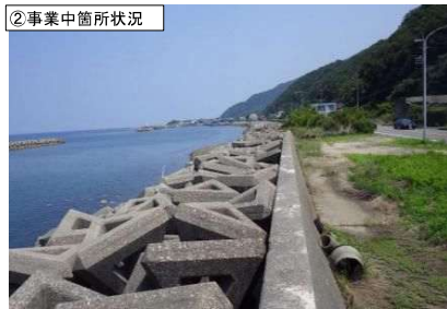
②事業中箇所状況
