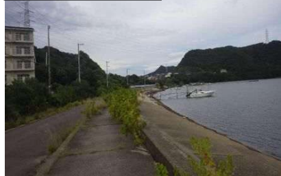
①護岸状況（西側・階段護岸）
