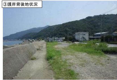
③護岸背後地状況
