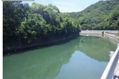
③護岸状況
