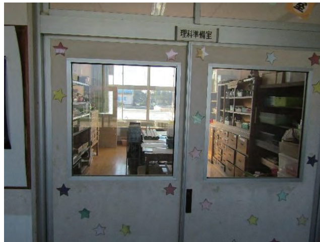
施設点検後の改善例 (擦りガラスを透明ガラスへ変更)
