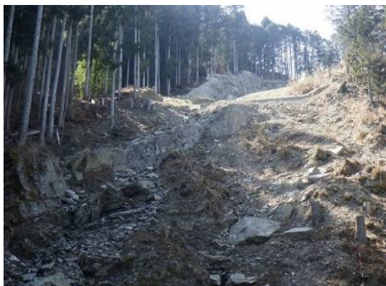
山腹崩壊により不安定な土砂等が堆積
