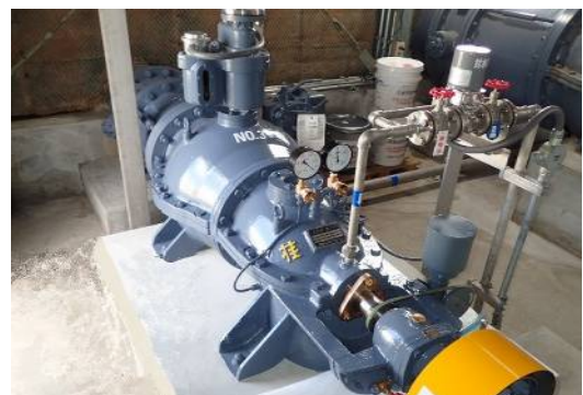
排水機 改修完了(鳴門市 矢倉西地区)
