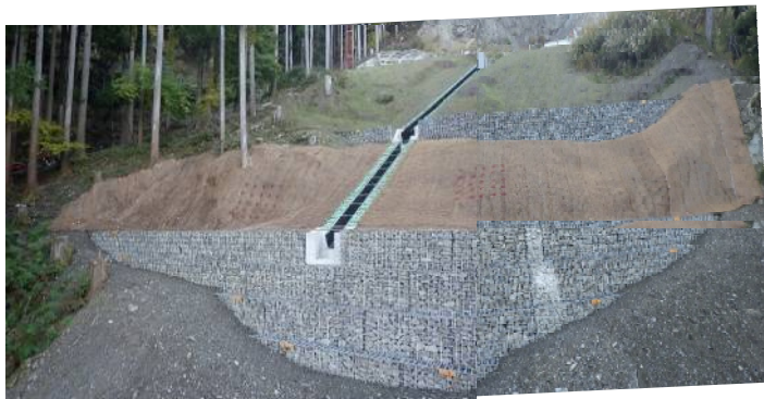
工事完了(山腹工)
