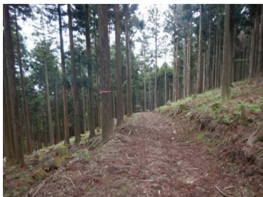
大川原旭丸線 大川原工区 (既設林道から作業道を開設し実施した間伐)
