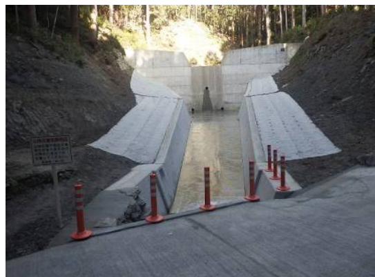
工事完了(溪間工)
