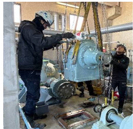
排水機 据付状況(鳴門市 大津西部地区)
