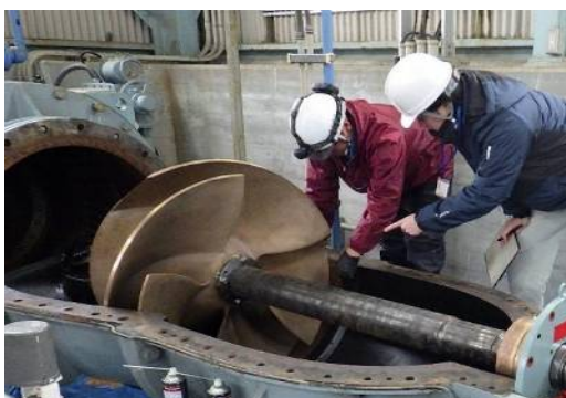
排水機 改修状況(鳴門市 恵美寿地区)
