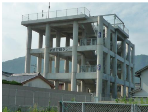
突喰津波避難タワー（海陽町突喰）
