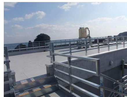
▲屋上は海拔18m(津波想定最大波高9m)の高さがあり、貯水タンクから飲み水を確保できます
