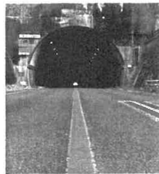
山川美郷・国道193号 (はみ出し禁止線の修繕)
