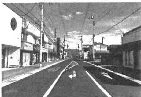
県道鴨島停車場線 (舗装の修繕)
