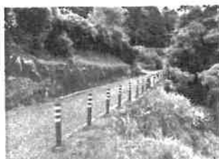
県道・神山川島線 (安全ポールの新設)
