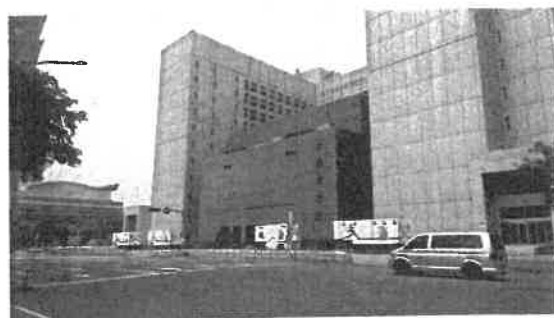
仮設トイレ（建物手前の白い設備）
