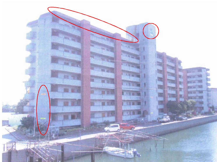
津波避難ビル整備工事 全景
