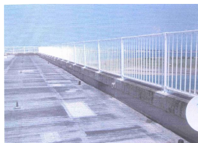
屋上手摺りの設置 約170m
