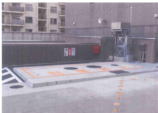
地下オイルタンク 10,000 リットル
