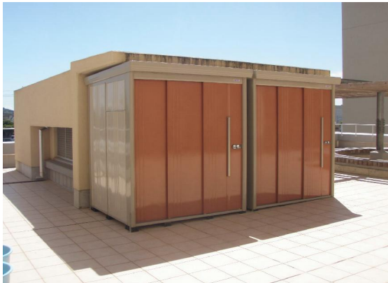
備蓄倉庫設置
