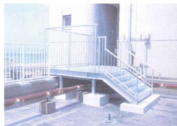
屋上へ上がるための 階段の設置
