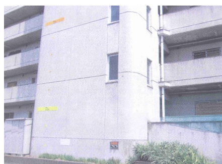
海拔表示板の設置
