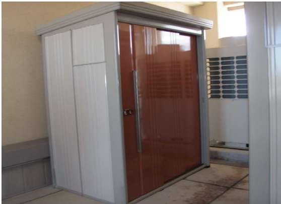
備蓄倉庫設置
