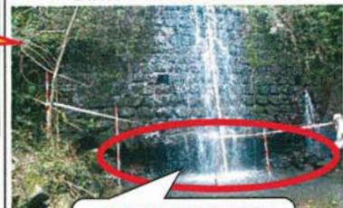
本堤の基礎洗掘 うただに (美馬市宇多谷)
