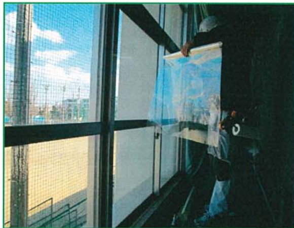
窓ガラス飛散防止フィルム貼り
