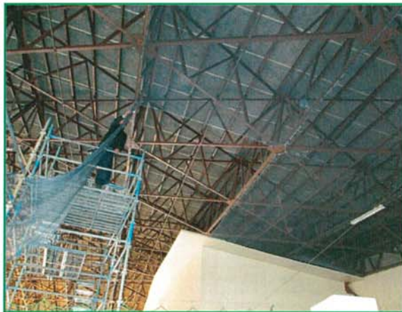
天井材落下防止ネット張り
