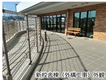
新校舎棟（外構工事）外観
