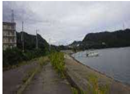
①護岸状況(西側・階段護岸)
