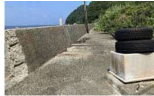
③護岸状況
