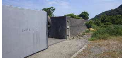
②護岸状況(西側)
