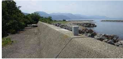
②護岸状況
