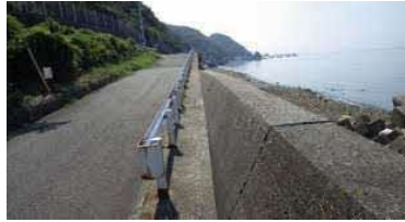
③護岸状況（旧道から）
