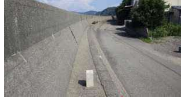
②護岸状況
