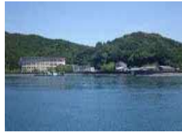
①海岸状況（全景・対岸より撮影）
