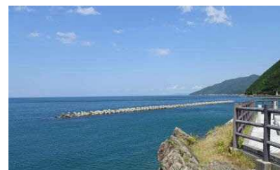
折野港海岸大須地区 の沖合い防護対策
