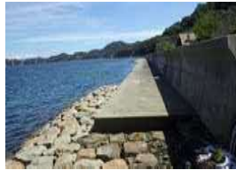
①海岸状況(埋立地)
