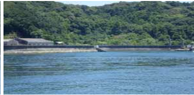
③海岸状況（対岸より撮影）
