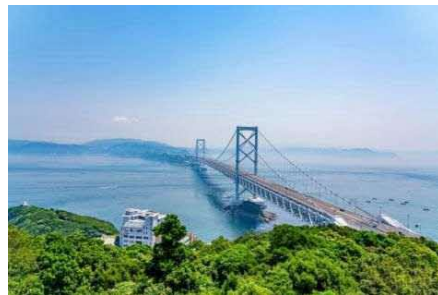
関西方面を結ぶ本四連絡橋
