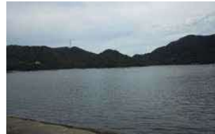
③護岸状況
