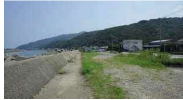
③護岸背後地状況
