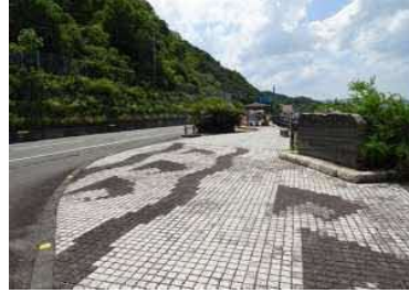
②休憩所状況
