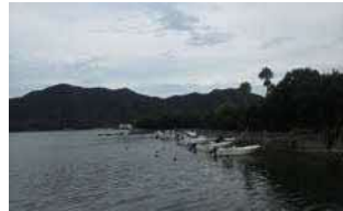
②護岸状況(北側)
