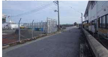
②護岸状況（南側）
