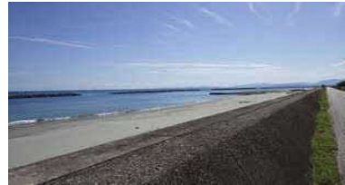
②護岸状況(北側)
