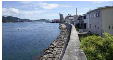
①護岸状況
