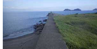
②突堤状況(最東側)
