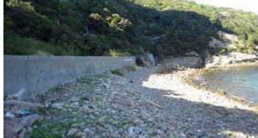
①護岸状況
