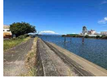
③護岸状況
