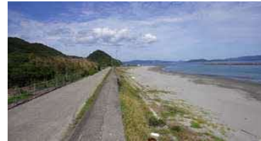
③護岸状況
