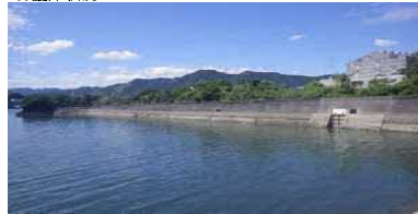
②護岸状況
