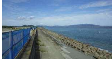
①護岸状況(南側)
