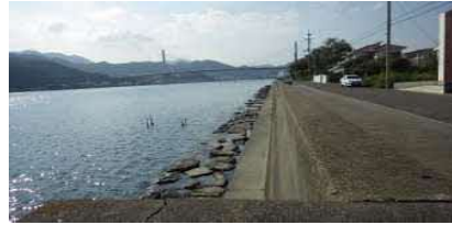
②護岸状況(中央)
