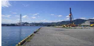
①護岸状況
