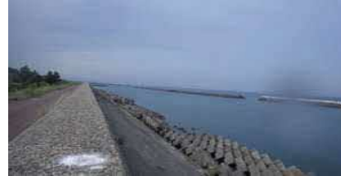
③護岸状況(西側)
