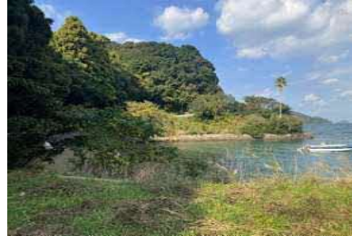
②護岸状況
