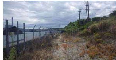
③護岸状況
