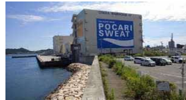
③護岸状況
