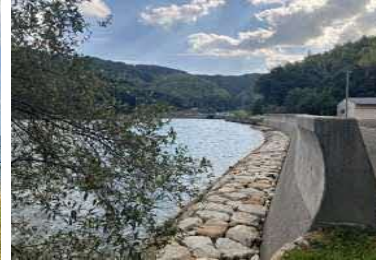
③護岸状況
