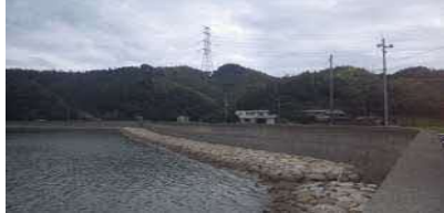
①護岸状況(改修済み)
