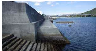
②護岸状況
