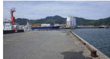
③護岸状況（南側）
