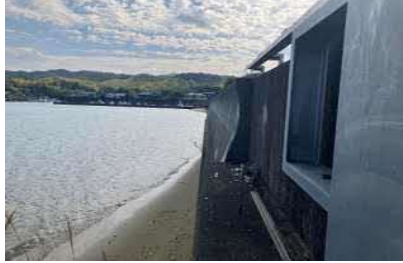
①護岸状況
