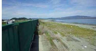
②護岸状況(北側)
