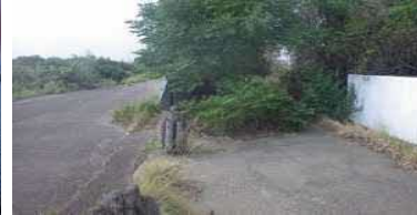
③護岸状況
