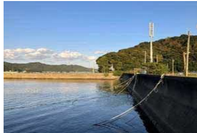
②護岸状況
