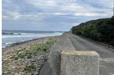
①護岸状況
