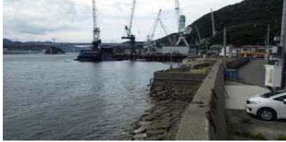
②護岸状況(東側)
