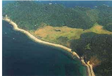
②護岸の状況
