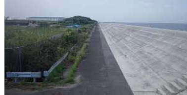
③管理道路と道路状況
