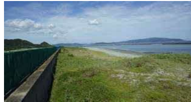
①護岸状況(南側)
