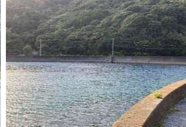
③護岸状況
