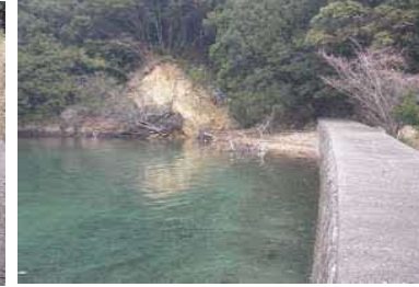
③護岸状況
