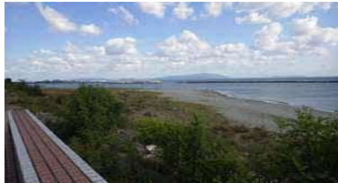
①護岸状況(南側)
