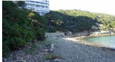
②護岸状況
