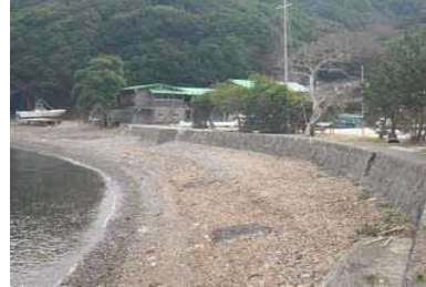
②護岸状況（保胎している）
