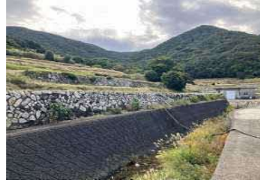
③護岸背後地状況
