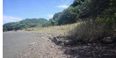
②護岸状況
