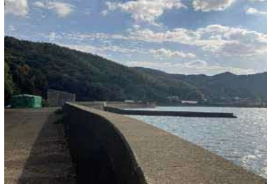
②護岸状況
