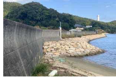
②護岸状況
