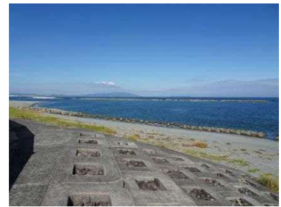
今切港海岸の緩傾斜護岸
