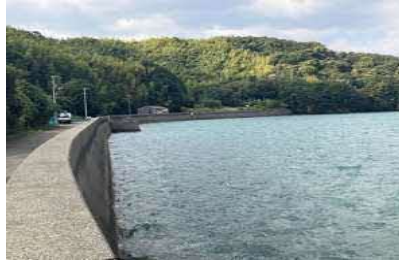
①護岸状況
