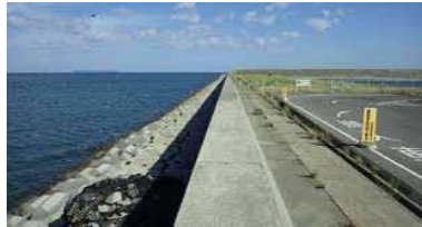
①護岸状況(東側)
