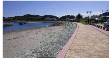
②護岸状況(背後は公園)
