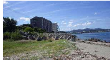
③護岸状況(東側)
