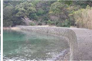
②護岸状況
