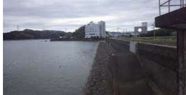
②護岸状況
