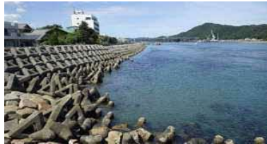
①護岸状況(階段護岸・管理棟)
