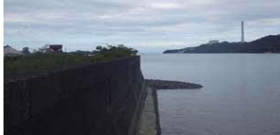
①護岸状況
