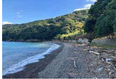
②護岸状況
