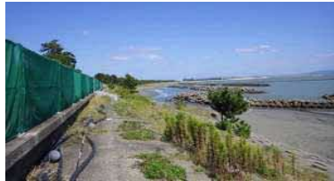
②護岸状況(北側)
