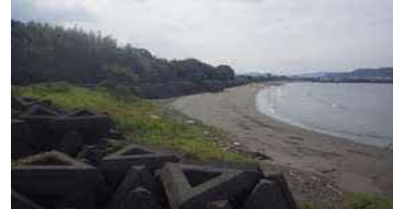
③護岸状況
