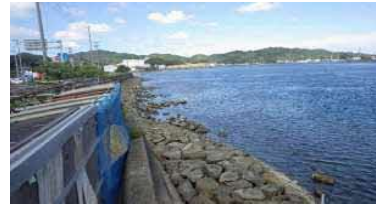
③護岸状況(その1南側)
