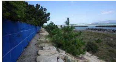
①護岸状況(南側)
