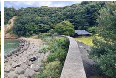
②護岸状況
