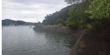
②護岸状況(未改修)
