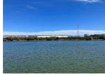
②護岸状況（埋立地東側）
