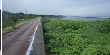
②護岸状況(東側)
