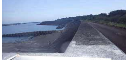
①護岸状況(東側)
