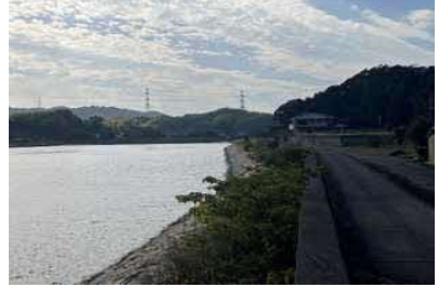
③護岸状況
