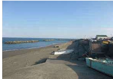
①護岸状況(北東側)
