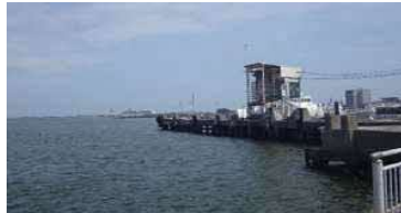
①護岸状況（全景）
