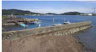
②護岸状況(その1最北側)
