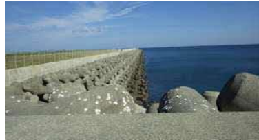
②護岸状況(南側)
