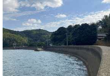
③護岸背後状況
