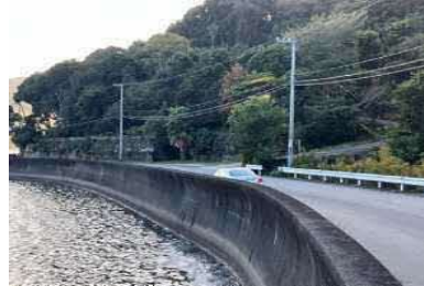
②護岸状況
