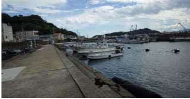
①護岸状況(西側)
