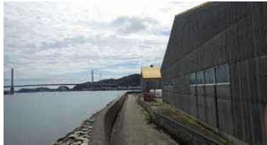
①護岸状況(その1北側)
