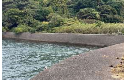
①護岸状況
