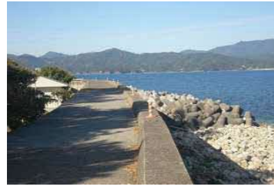
②護岸状況
