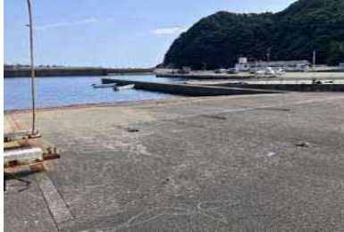
①護岸状況（漁港）
