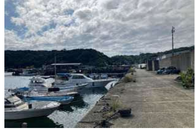
②護岸状況
