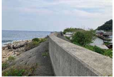
①護岸状況
