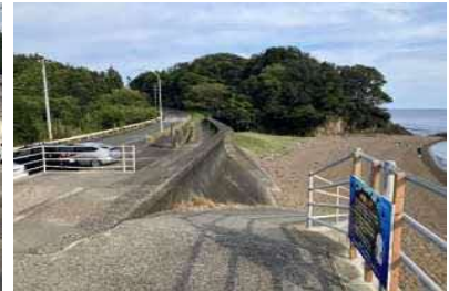
③護岸状況
