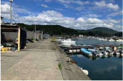
①護岸状況
