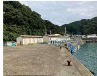
③護岸状況
