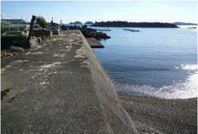
②護岸状況
