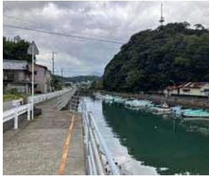
①護岸状況
