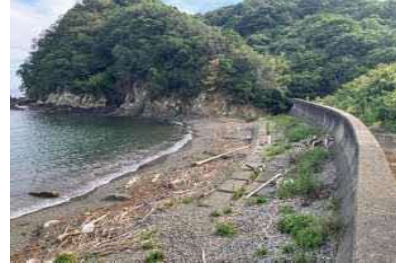
②護岸状況
