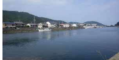
②護岸状況
