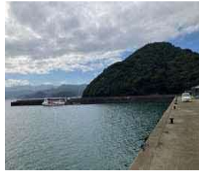
①護岸状況
