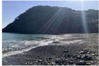
②護岸状況
