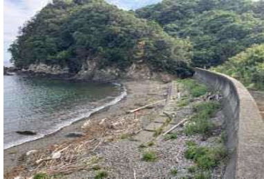
②護岸状況
