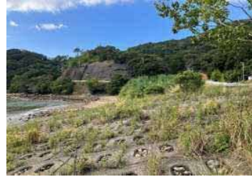
③護岸状況
