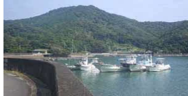
③護岸状況
