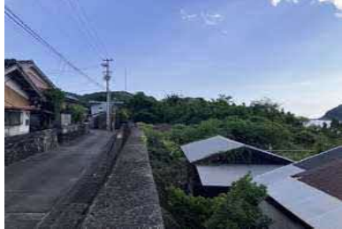
①護岸状況
