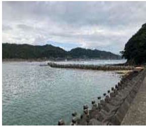
①護岸状況
