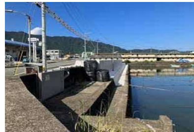
③護岸状況
