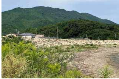
①護岸状況
