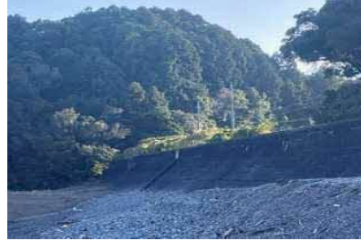
③護岸状況
