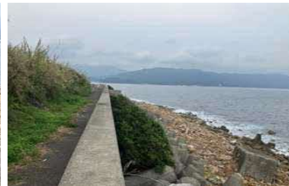
③護岸状況
