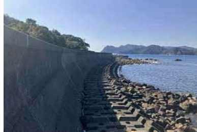
①護岸状況
