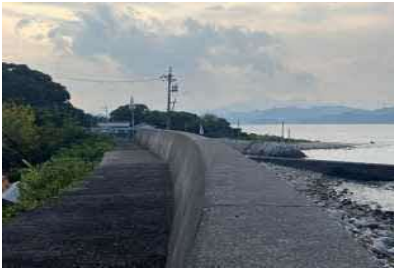
①護岸状況
