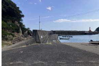
②護岸状況
