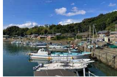
③護岸状況
