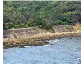
③護岸状況
