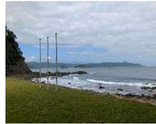
③護岸背後状況
