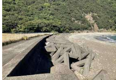
③護岸状況
