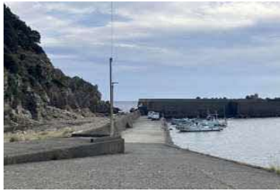
②護岸状況
