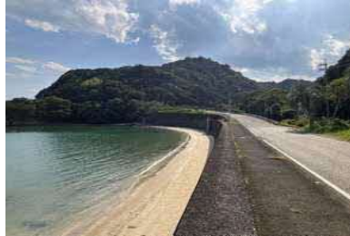
②護岸状況
