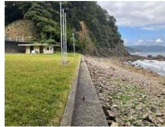
②護岸状況
