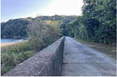
①護岸状況
