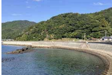
②護岸状況
