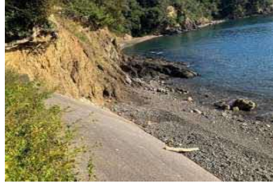
②護岸状況
