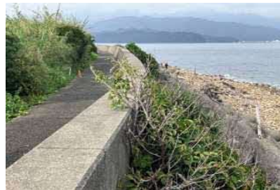
②護岸状況
