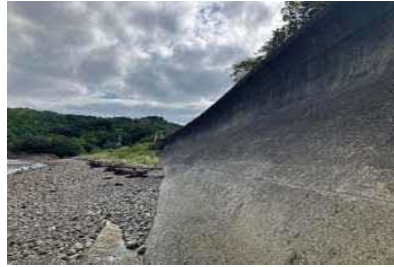
②護岸状況
