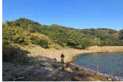
②護岸状況
