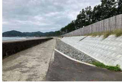
②護岸状況
