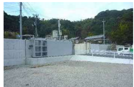
牟岐漁港海岸（楠ノ浦地区）での津波・高潮対策のための陸開
