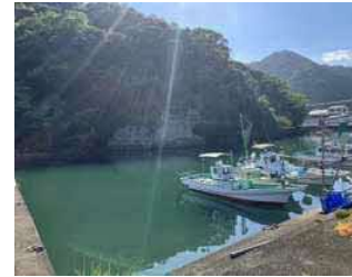
③海岸状況（島部）
