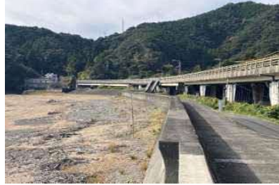
②護岸状況
