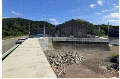
③護岸状況
