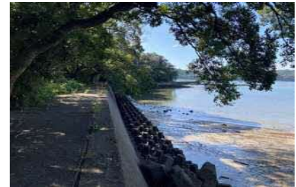
③護岸状況
