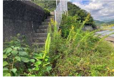
③護岸状況（階段工）
