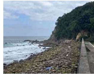
③護岸状況
