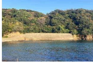
③護岸状況
