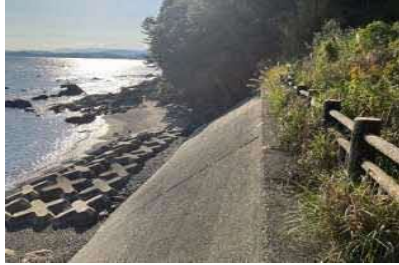
①護岸状況
