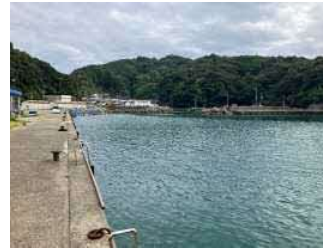
②護岸状況
