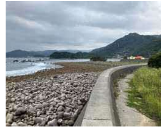
③護岸状況
