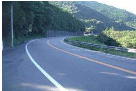
主要道路網である国道55号
