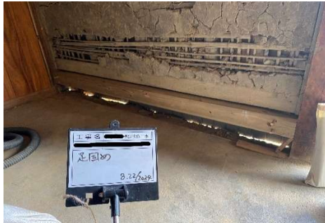
足固め施工状況
