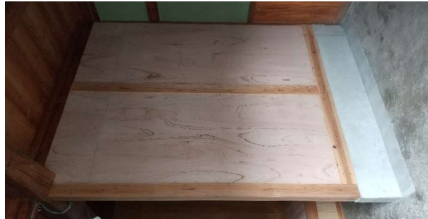
新設基礎及び耐力壁
