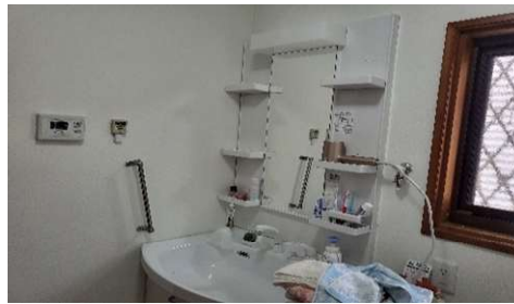
改修後 (壁補強後、化粧台取替)
