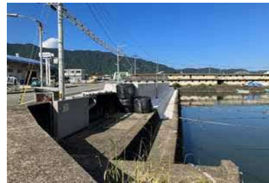
③護岸状況
