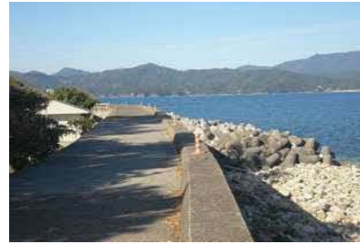
②護岸状況
