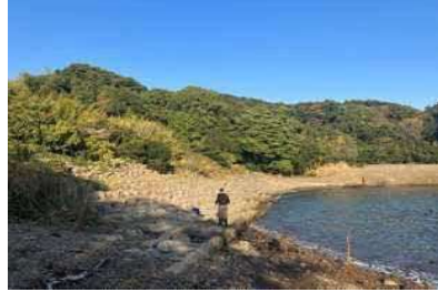
②護岸状況
