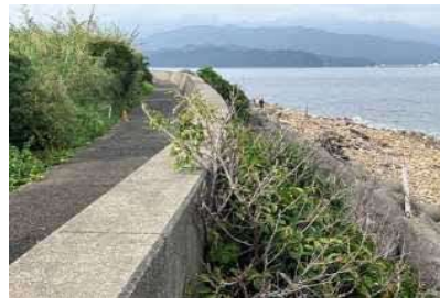
②護岸状況
