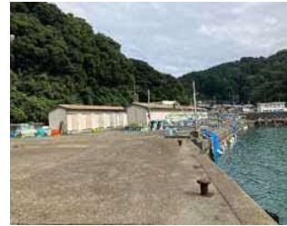
③護岸状況
