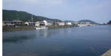
②護岸状況
