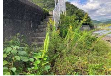
③護岸状況（階段工）
