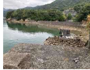
③船だまり状況
