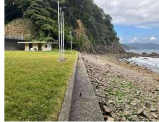
②護岸状況
