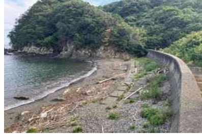
②護岸状況
