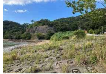
③護岸状況
