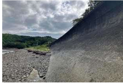
②護岸状況
