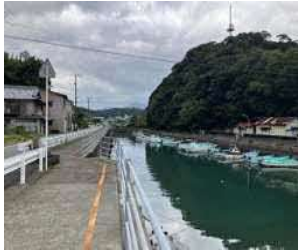
①護岸状況
