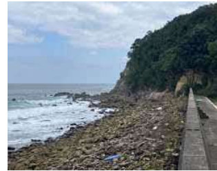
③護岸状況
