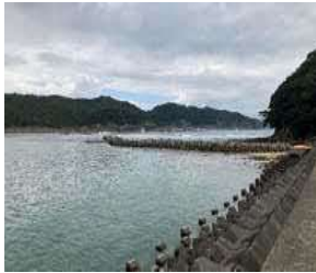
①護岸状況
