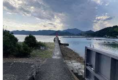
③突堤状況
