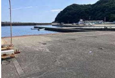
①護岸状況（漁港）
