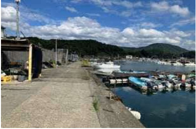
①護岸状況
