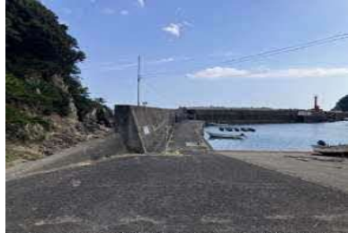
②護岸状況
