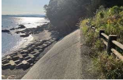
①護岸状況
