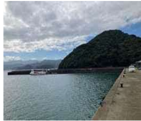
①護岸状況
