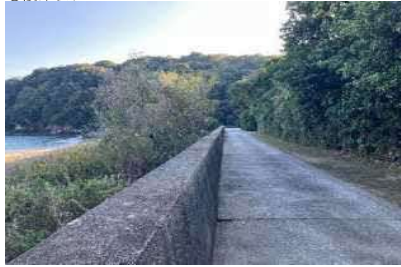
①護岸状況
