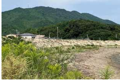
①護岸状況
