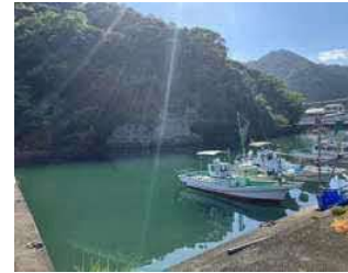
③海岸状況（島部）
