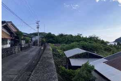
①護岸状況
