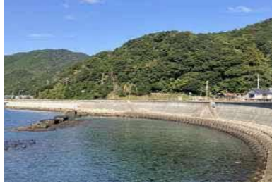
②護岸状況
