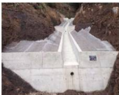
(山腹工（水路工）：海陽町船津地区)
