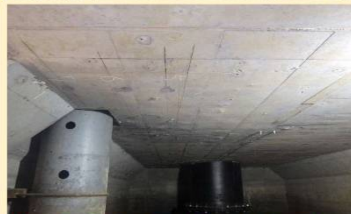
①ポンプ場(ポンプ井)の耐震化(津田中央ポンプ場)
