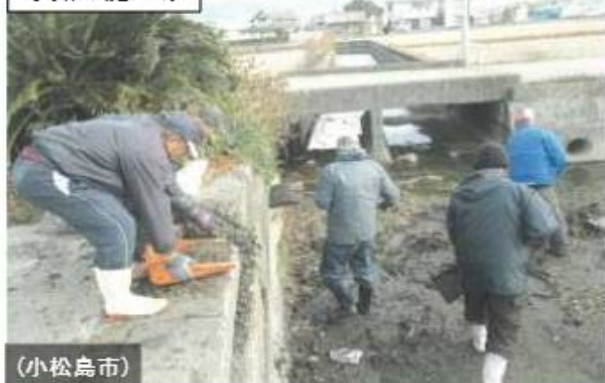
水路の泥上げ
