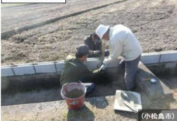
水路の維持管理
