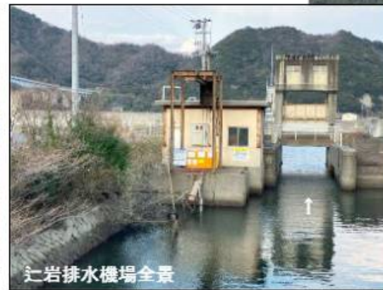
排水機場長寿命化工事：江岩排水機場長寿命化工事
