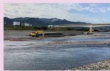
河道掘削の実施状況写真
