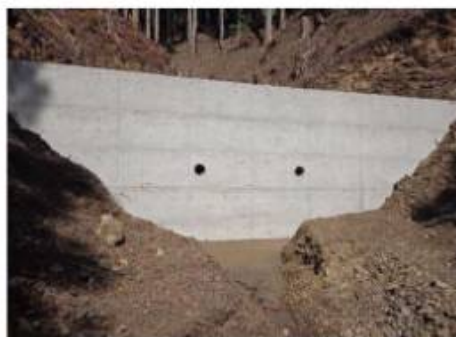
(治山ダム工：上勝町杉地地区)
