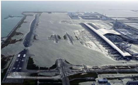
高潮による関西空港の水没状況
