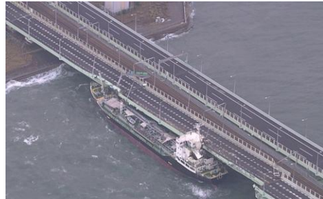
強風に流され関西空港連絡橋に衝突したタンカー
