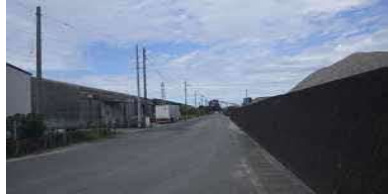
②護岸状況
