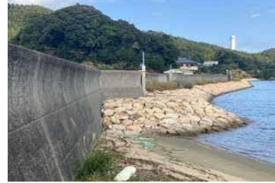
②護岸状況
