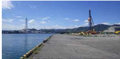
①護岸状況
