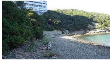
②護岸状況
