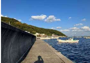
③護岸状況
