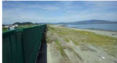
②護岸状況(北側)
