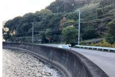
②護岸状況
