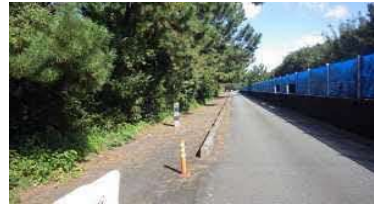
③堤防背後の管理道路と自転車道路
