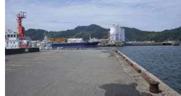
③護岸状況（南側）
