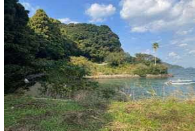
②護岸状況
