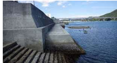
②護岸状況
