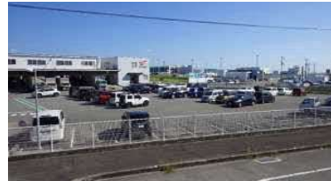
③背後地状況(工業団地)
