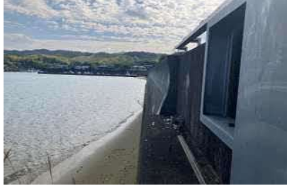
①護岸状況
