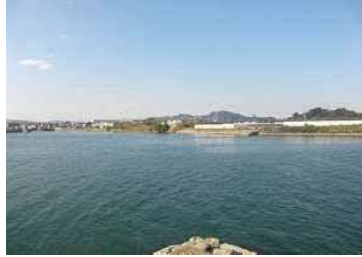
①岸壁状況(埋立地中央)
