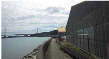
①護岸状況(その1北側)
