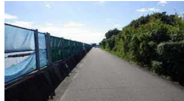
③管理道路と斜路
