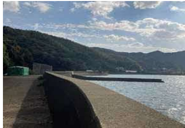
②護岸状況
