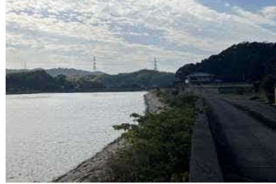
③護岸状況
