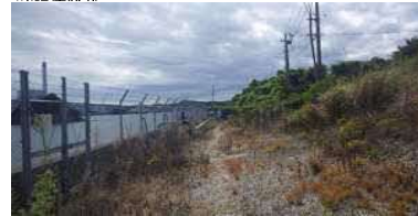
③護岸状況
