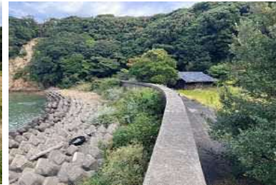
②護岸状況
