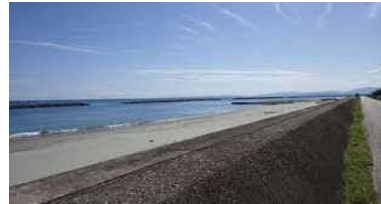
②護岸状況(北側)
