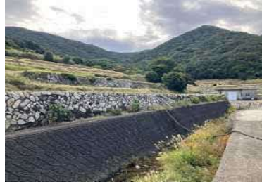
③護岸背後地状況
