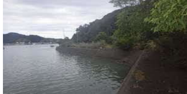
②護岸状況（未改修）
