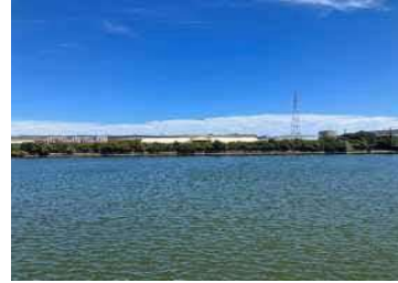
②護岸状況(埋立地東側)
