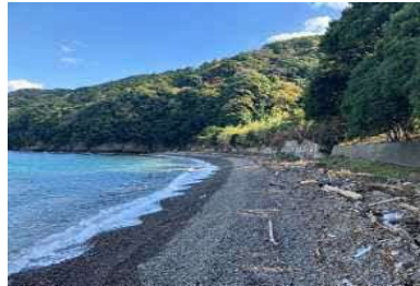
②護岸状況
