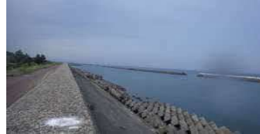
③護岸状況(西側)
