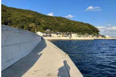
①護岸状況
