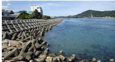
①護岸状況(階段護岸・管理棟)
