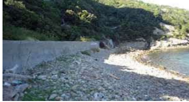
①護岸状況
