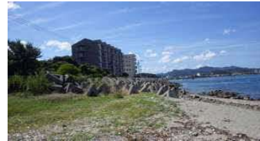
③護岸状況(東側)
