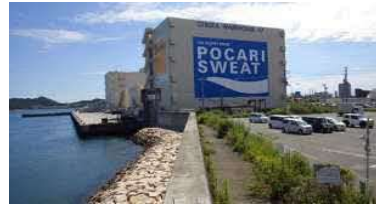
③護岸状況
