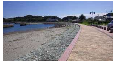
②護岸状況(背後は公園)
