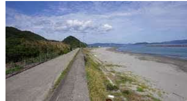
③護岸状況
