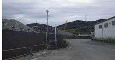
③護岸状況
