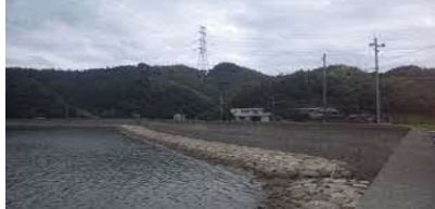
①護岸状況（改修済み）
