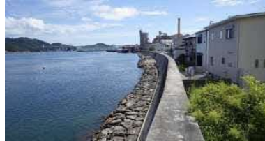
①護岸状況
