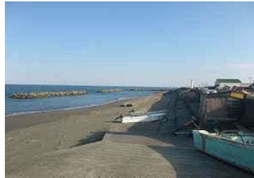
①護岸状況(北東側)
