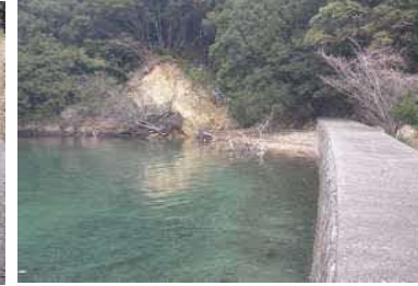
③護岸状況
