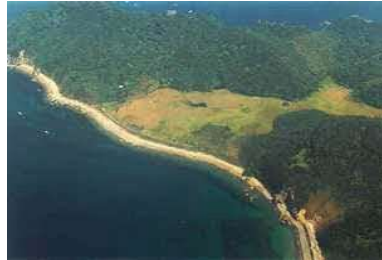
②護岸の状況
