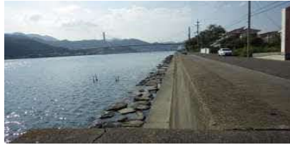
②護岸状況(中央)
