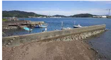
②護岸状況(その1最北側)
