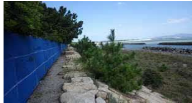
①護岸状況(南側)
