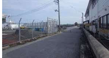
②護岸状況（南側）
