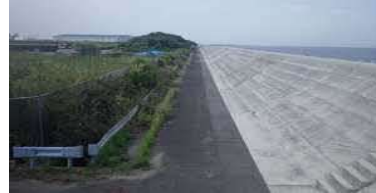
③管理道路と道路状況
