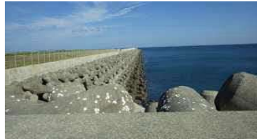
②護岸状況(南側)
