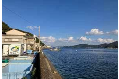
②護岸状況
