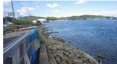
③護岸状況(その1南側)
