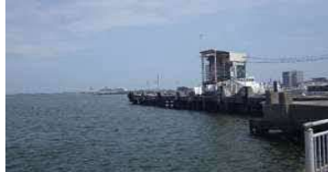
①護岸状況（全景）
