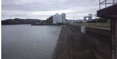
②護岸状況
