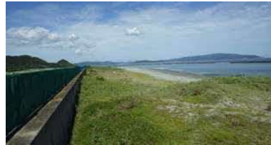
①護岸状況(南側)
