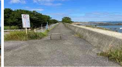
③背後地状況（南側・自転車道と車道あり）
