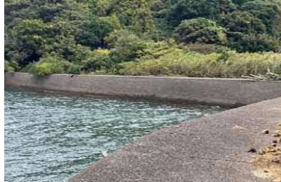
①護岸状況
