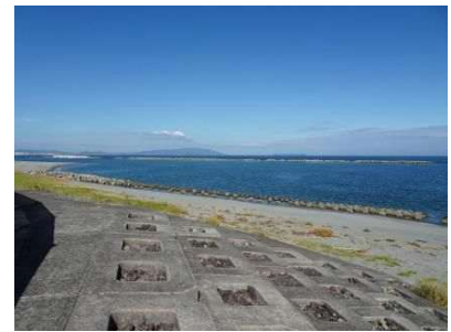
今切港海岸の緩傾斜護岸
