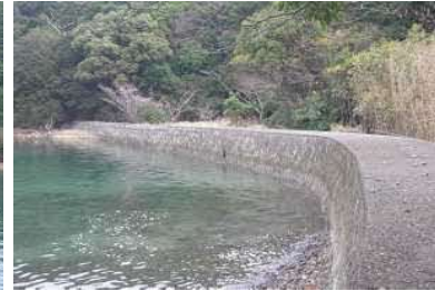
②護岸状況
