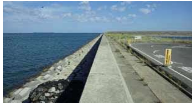
①護岸状況(東側)
