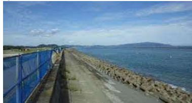
①護岸状況(南側)
