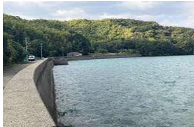
①護岸状況
