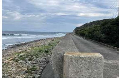
①護岸状況
