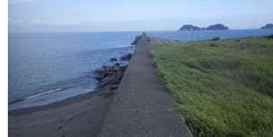
②突堤状況(最東側)
