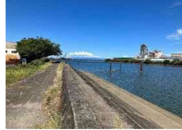
③護岸状況
