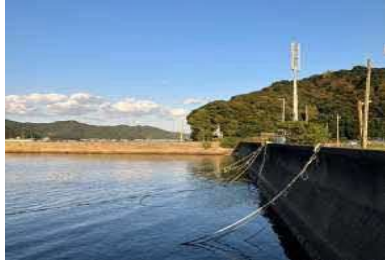
②護岸状況
