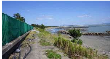
②護岸状況(北側)
