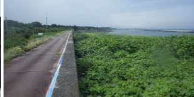
②護岸状況(東側)
