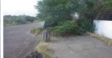
③護岸状況
