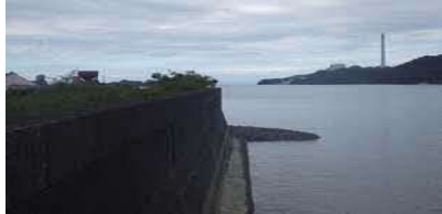
①護岸状況
