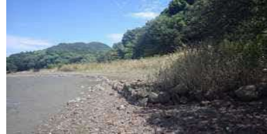
②護岸状況
