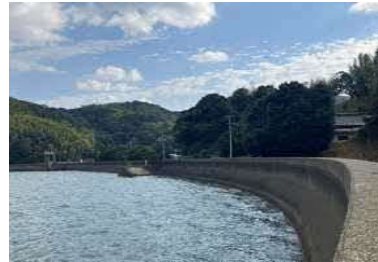
③護岸背後状況
