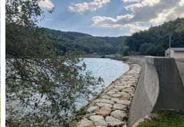
③護岸状況
