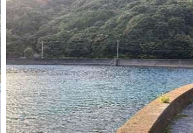
③護岸状況
