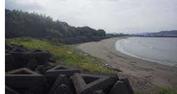
③護岸状況
