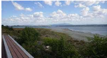
①護岸状況(南側)
