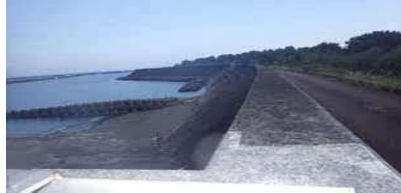
①護岸状況(東側)
