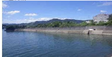
②護岸状況
