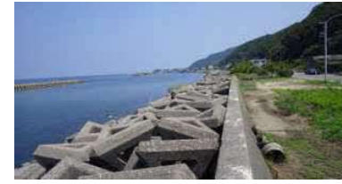
②事業中箇所状況
