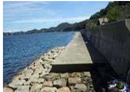
①海岸状況(埋立地)
