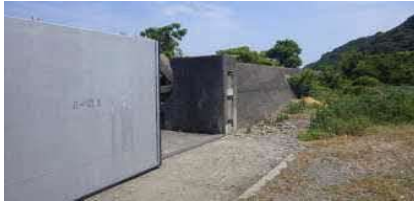
②護岸状況(西側)
