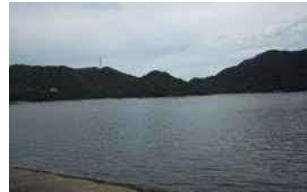
③護岸状況
