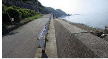
③護岸状況（旧道から）
