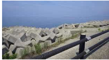
②斜路状況
