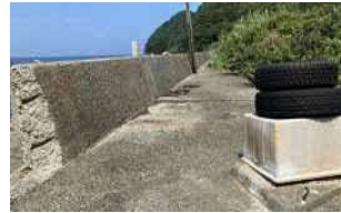
③護岸状況
