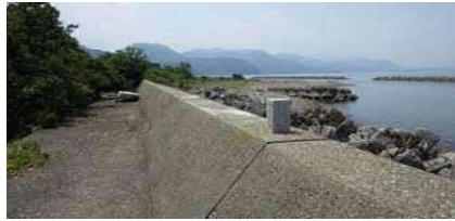
②護岸状況
