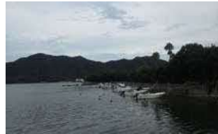
②護岸状況(北側)
