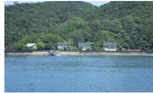
②海岸状況（対岸より撮影）
