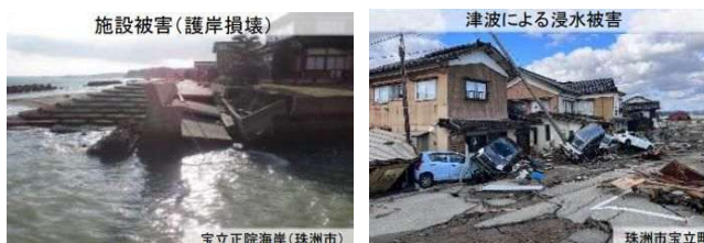
能登半島地震での津波被害
