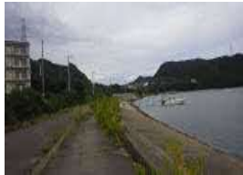
①護岸状況(西側・階段護岸)
