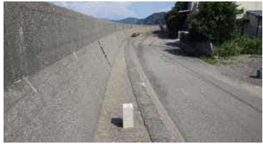
②護岸状況
