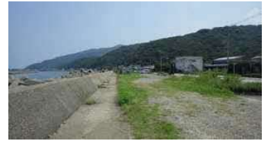
③護岸背後地状況
