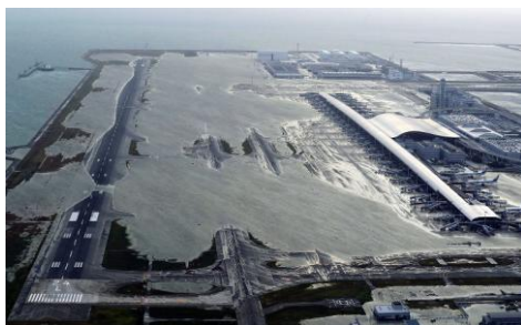
高潮による関西空港の水没状況
