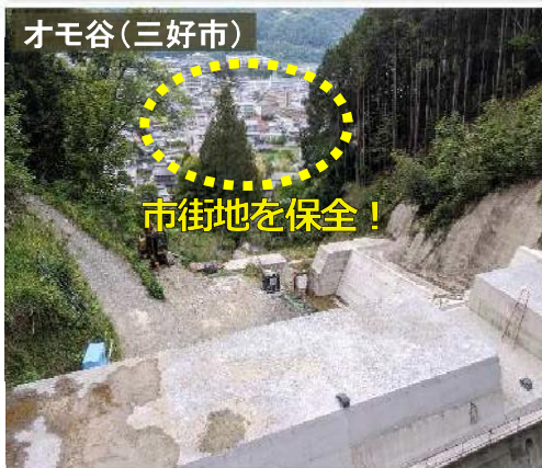
砂防堰堤の整備
