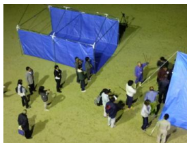
仮設テントの設営
