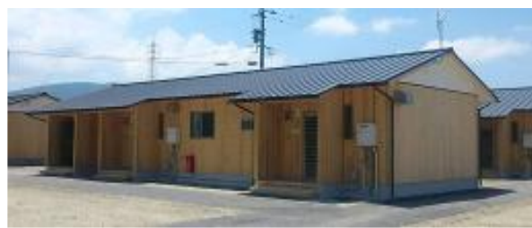
木造応急仮設住宅
