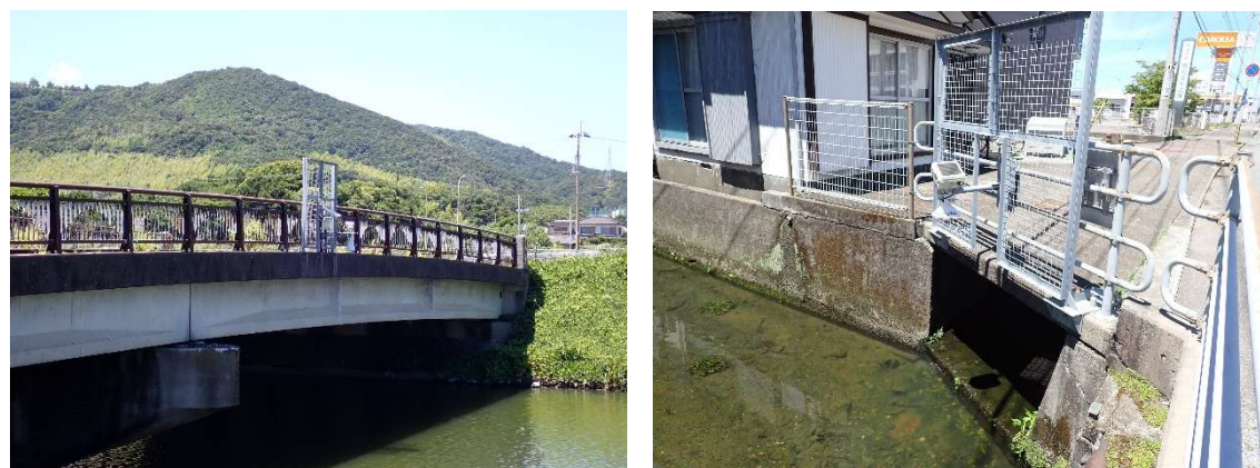
写真 4-2 危機管理型水位計設置状況
