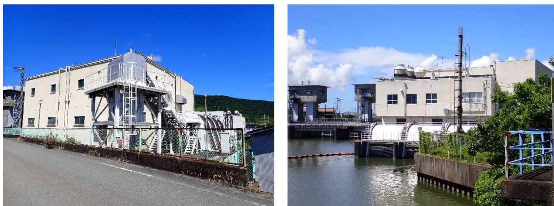
写真 4-1 水位観測施設
