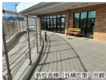
新校舎棟（外構工事）外観
