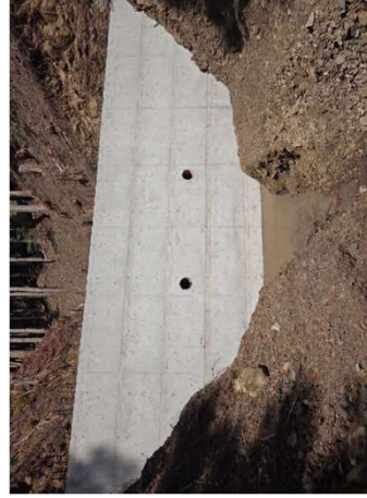
(治山ダム工：上勝町杉地地区)
