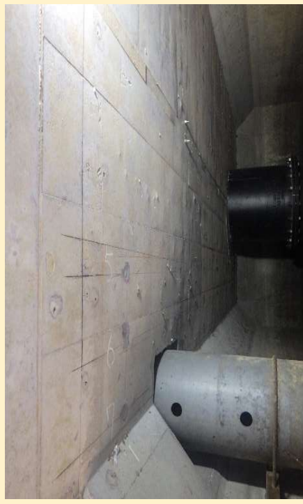
①ポンプ場（ポンプ井）の耐震化（津田中央ポンプ場）
