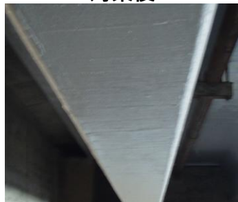
橋梁修繕事例 (橋梁下面の断面修復)
