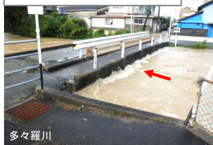
平成28年台風第16号時水位上昇状況
