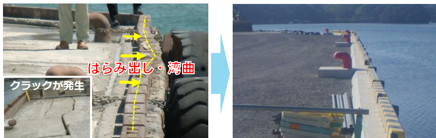
橘港(西浜地区) 【岸壁の補強】
