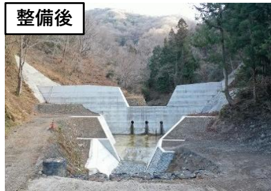
宇多谷 砂防堰堤 (美馬市)
