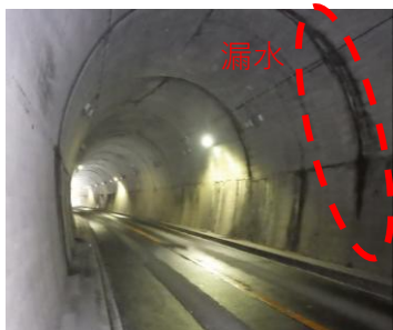
トンネル修繕事例 (漏水対策)
