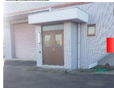
出島川排水機場
