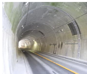
トンネル修繕事例 (漏水対策)
