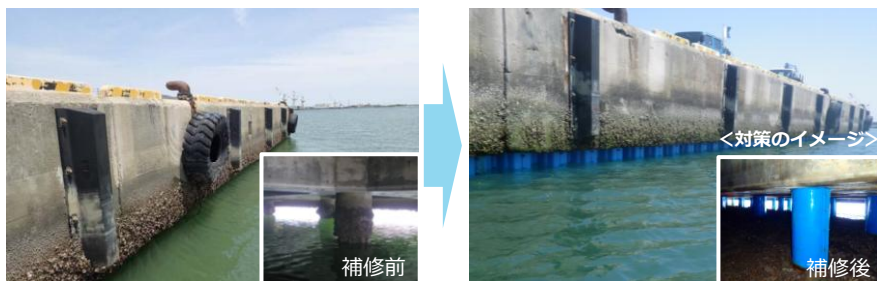
栗津港(里浦地区) 【岸壁の被覆防食工】
