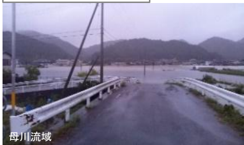
平成26年台風第12号浸水状況
